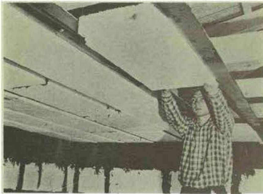
↑ نصب صفحات استیروپور در سقف سردخانه‌ها
