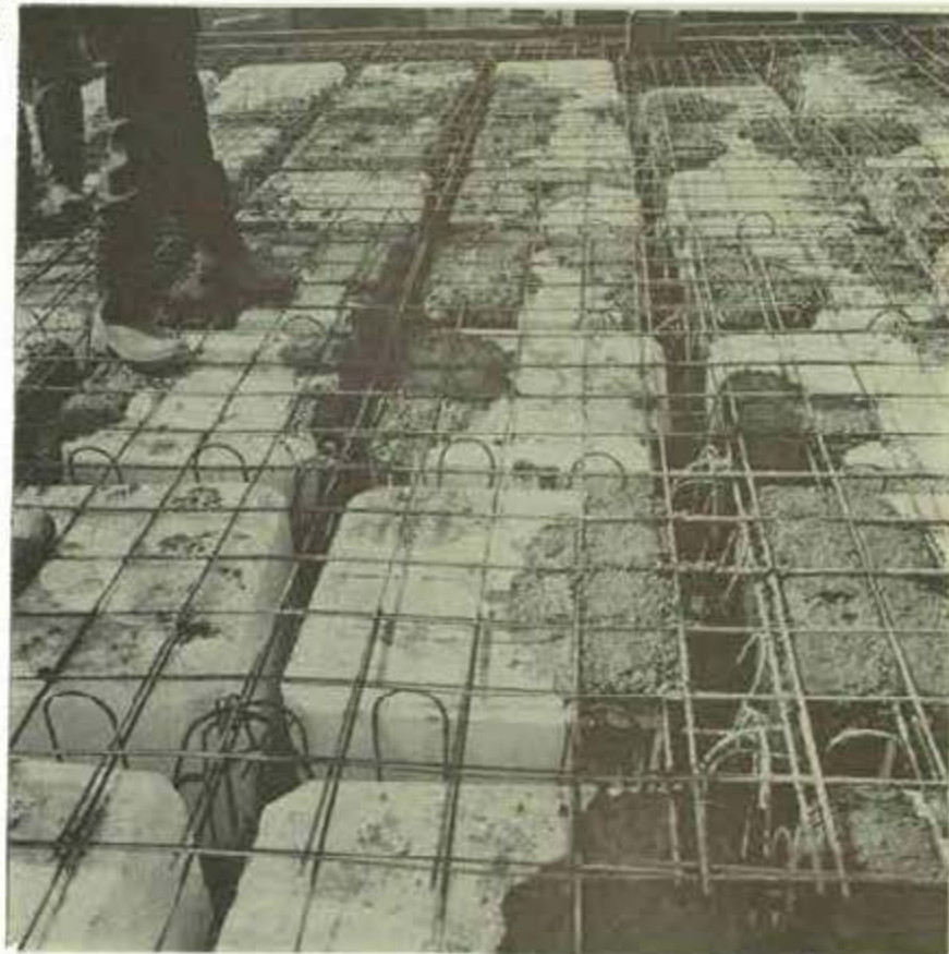
↑ نصب صفحات استیروپور در سقف سردخانه‌ها
