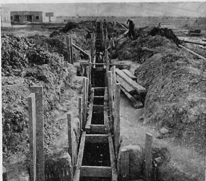
۲۸۸ - زه کشی بمق ۵/۵ در حوالی خانه های کارگران در بندر معشور - به علت وجود آب در عمق کم بوسیله تلمبه آب تخلیه میشود
