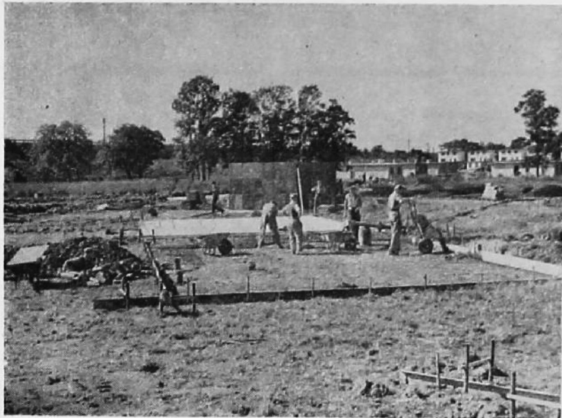
ش ۳۲۴ - اولین مرحله ساختمانی یعنی پی سازی
